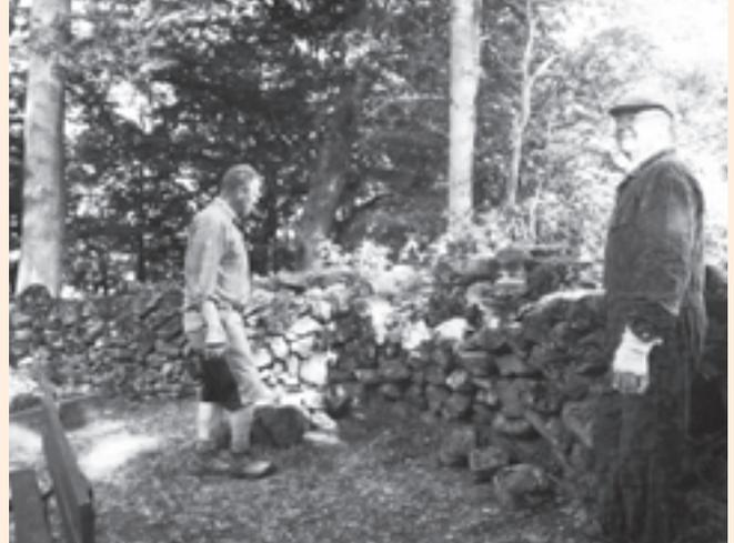
gezeigt und Teile der Trockenmauer in Stand gesetzt. Dabei wurde darauf geachtet, dass bereits vermooste Abdeckplatten wieder als oberster Abschluss zur Verwendung kamen.
