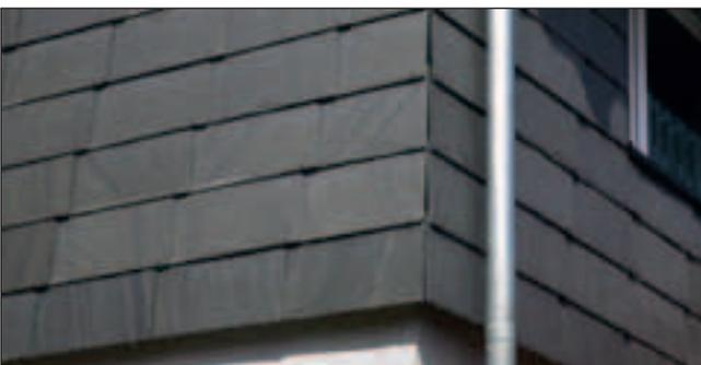
*Die neue wärmegeämmte Fassade*
